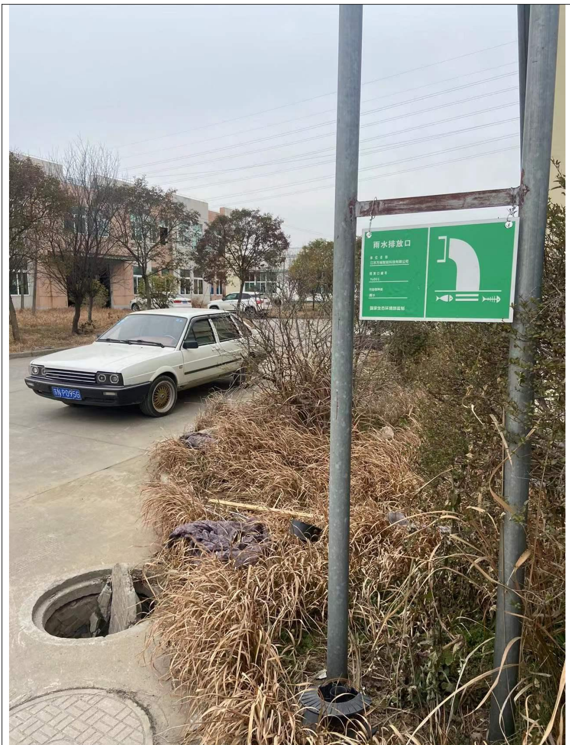
厂区雨水排口
