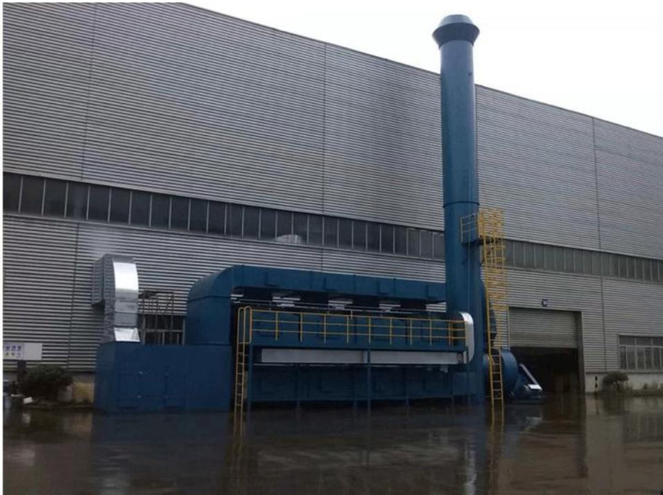
图 7-2 活性炭吸附脱附+催化燃烧装置示例图
