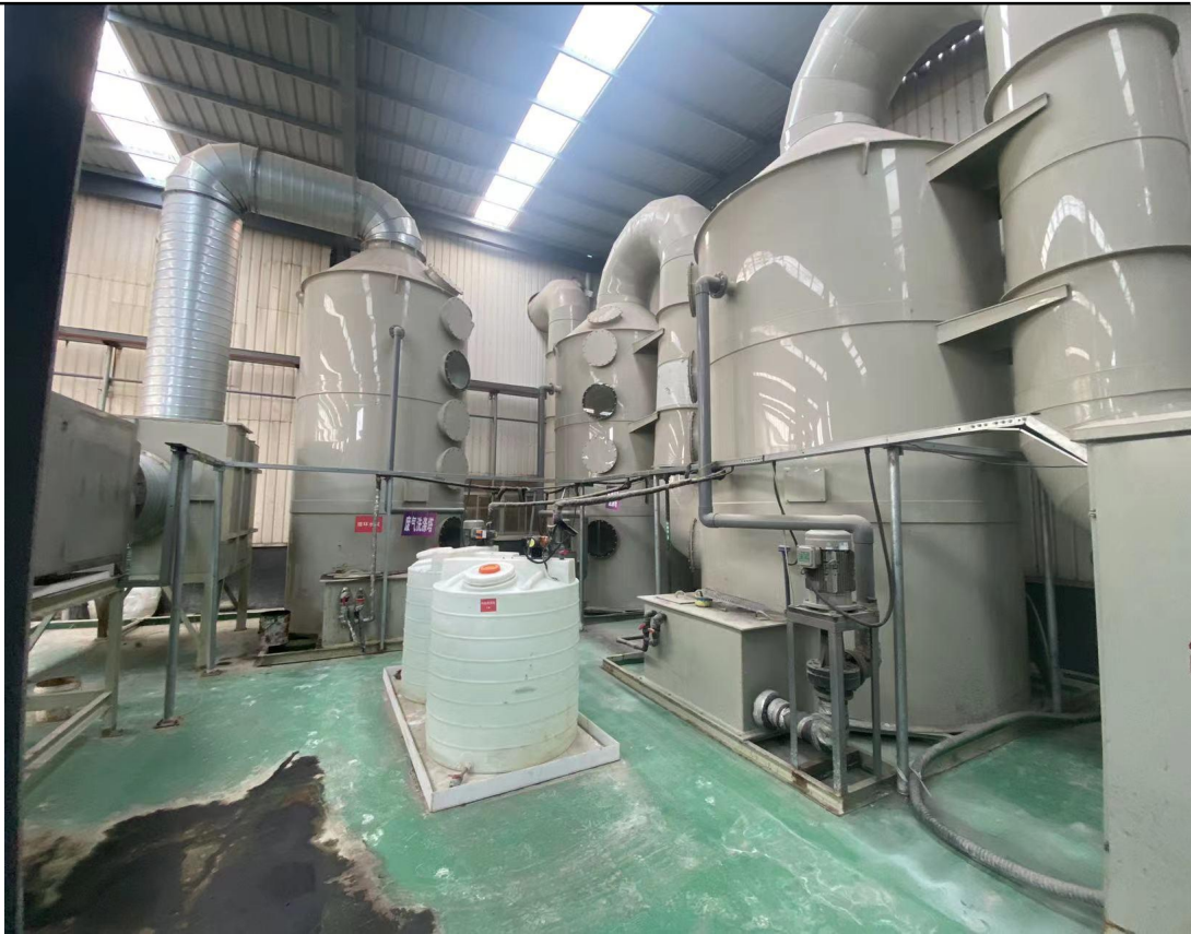
酸洗除锈废气处理设施：碱液吸收，DA004
