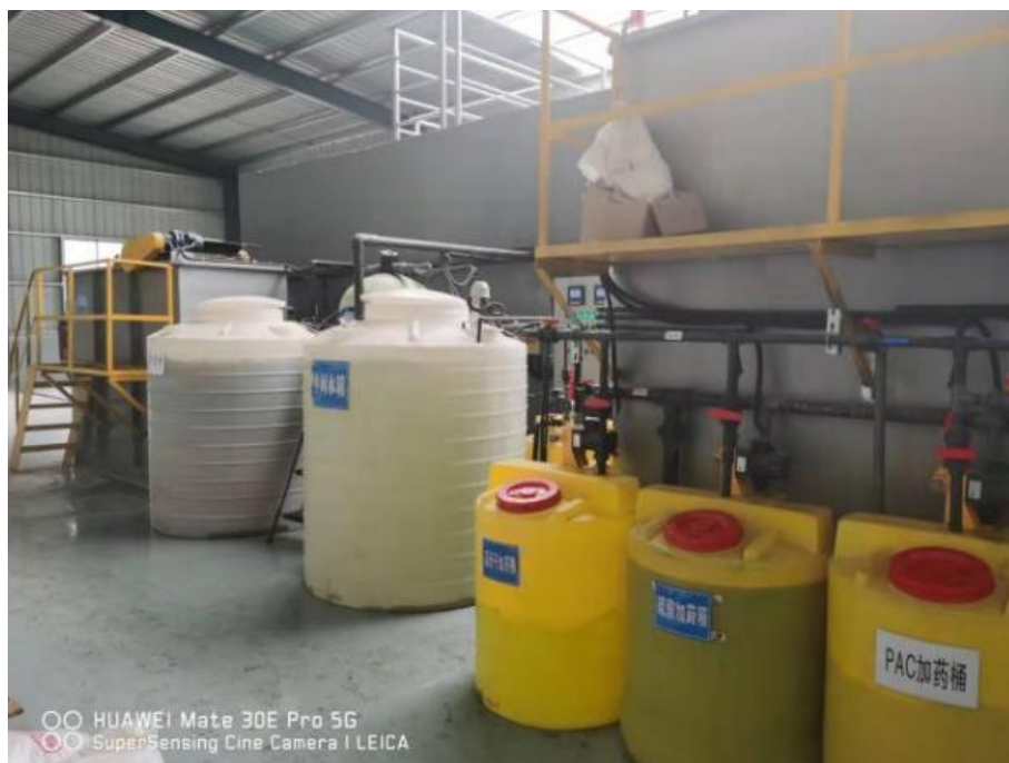
新建污水处理站
