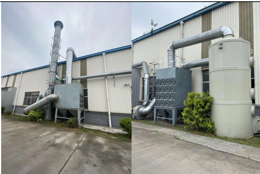
酸洗除锈废气处理设施：碱液吸收，DA004
